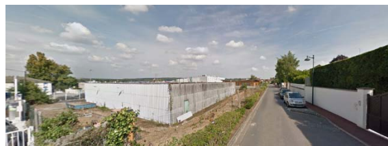
Clôtures peu qualitatives donnant sur le chemin des Marâtres en frange de la zone pavillonnaire de Saint-Thibault-des-Vignes.
