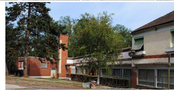
Ancienne usine Frankel – Rue du Chariot d'Or : Rue du Canada
