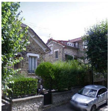
Quelques exemples des divers matériaux de façade rencontrés à Lagny-sur-Marne
