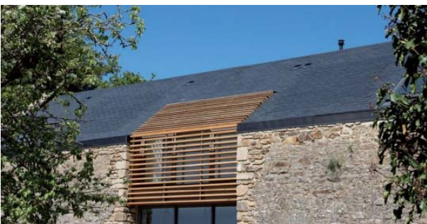
Si l'ardoise est possible, les ardoises solaires sont une solution : le capteur thermique est invisible, il est couvert d'ardoises
