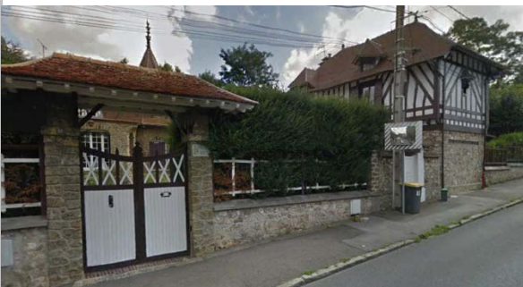
Construction accompagnée d'un mur de clôture d'intérêt, rue Saint-Laurent
