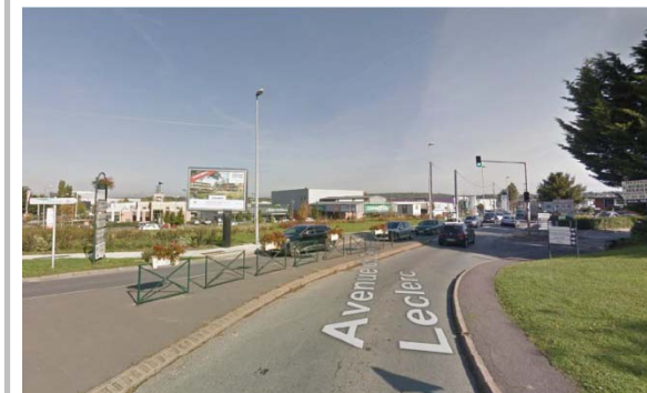
Entrée n° 3 – RD 418
