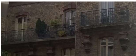
Des garde-corps qui participent à la qualité et à l'animation de la façade
