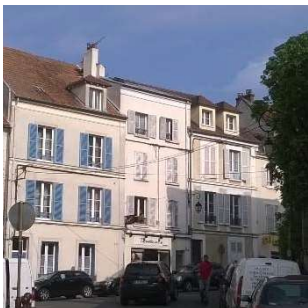
Continuité urbaine assurée par l'implantation des constructions à l'alignement
