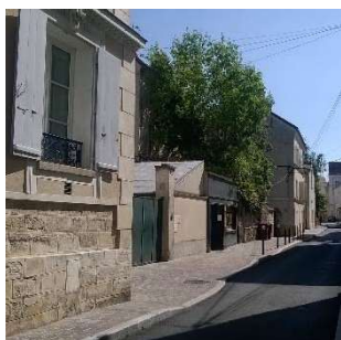
Continuité de l'alignement assurée par le mur de clôture
